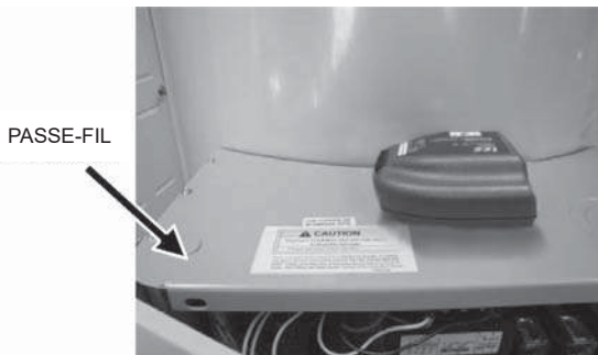
Figure 32. Passe-fil dans le coin gauche du panneau supérieur
