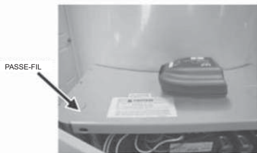
Figure 20. Emplacement du passage de câble de communication
