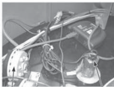
CONTACTEUR D'ÉCHAPPEMENT SONDE DE TEMPÉRATURE SUPÉRIEURE
